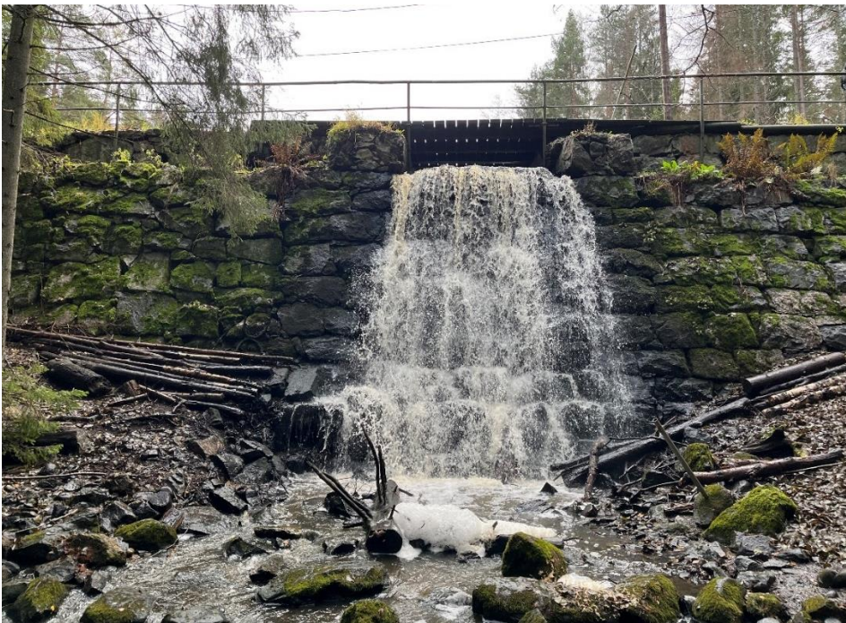
Figur 4. Stora dammens dammkonstruktion och fall. På dammkonstruktionen finns ett motions- och elljusspår. Foto: Sweco/Nicole Österberg, 2024-03-26.
