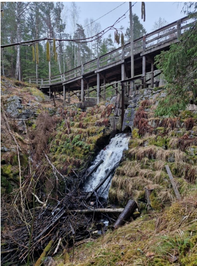
Figur 6. Lilla dammens dammkonstruktion. På dammkonstruktionen finns ett motions- och elljusspår. Foto: Sweco/Nicole Österberg, 2024-03-26.
